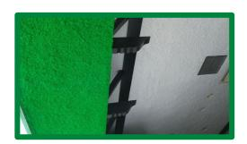
Está especialmente indicado como **aislante acústico** ya que al aplicarse mediante el sistema de **proyectado**, su acabado rugoso le confiere una excelente capacidad de absorción del ruido. Una vez aplicado, puede pintarse con pistola.
